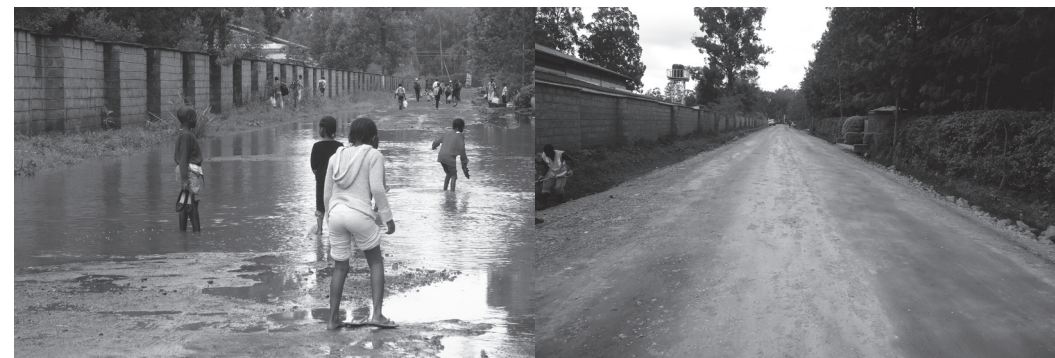
写真左：施工前、写真右：施工後(道普請人提供)
